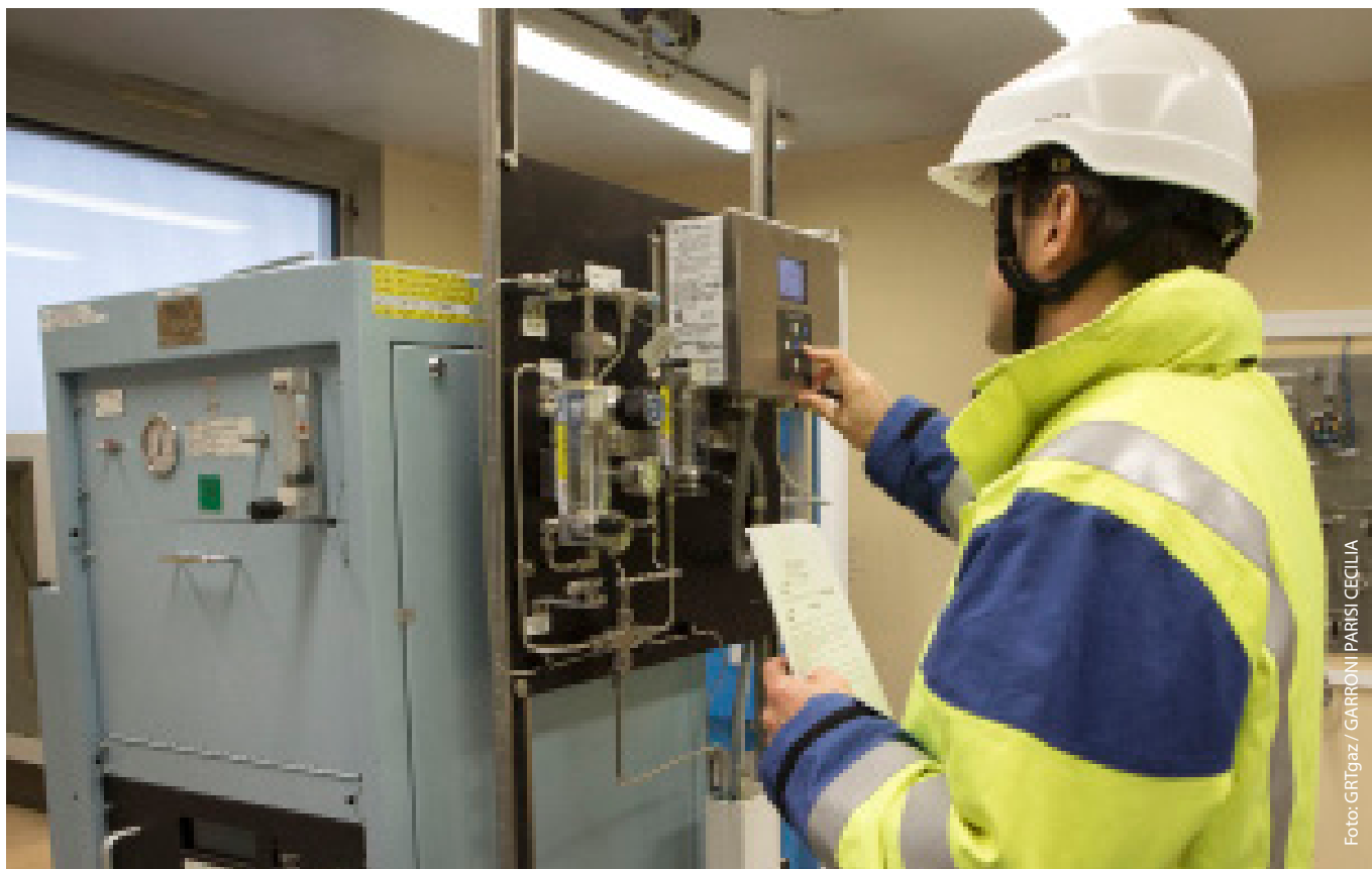
Propojovací stanice v Arleux-en-Gohelle, kde se provádí analýzy zemního plynu
