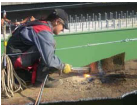
Kyslíkový rezací horák „naruší“ aj masívny ocelový plech.
