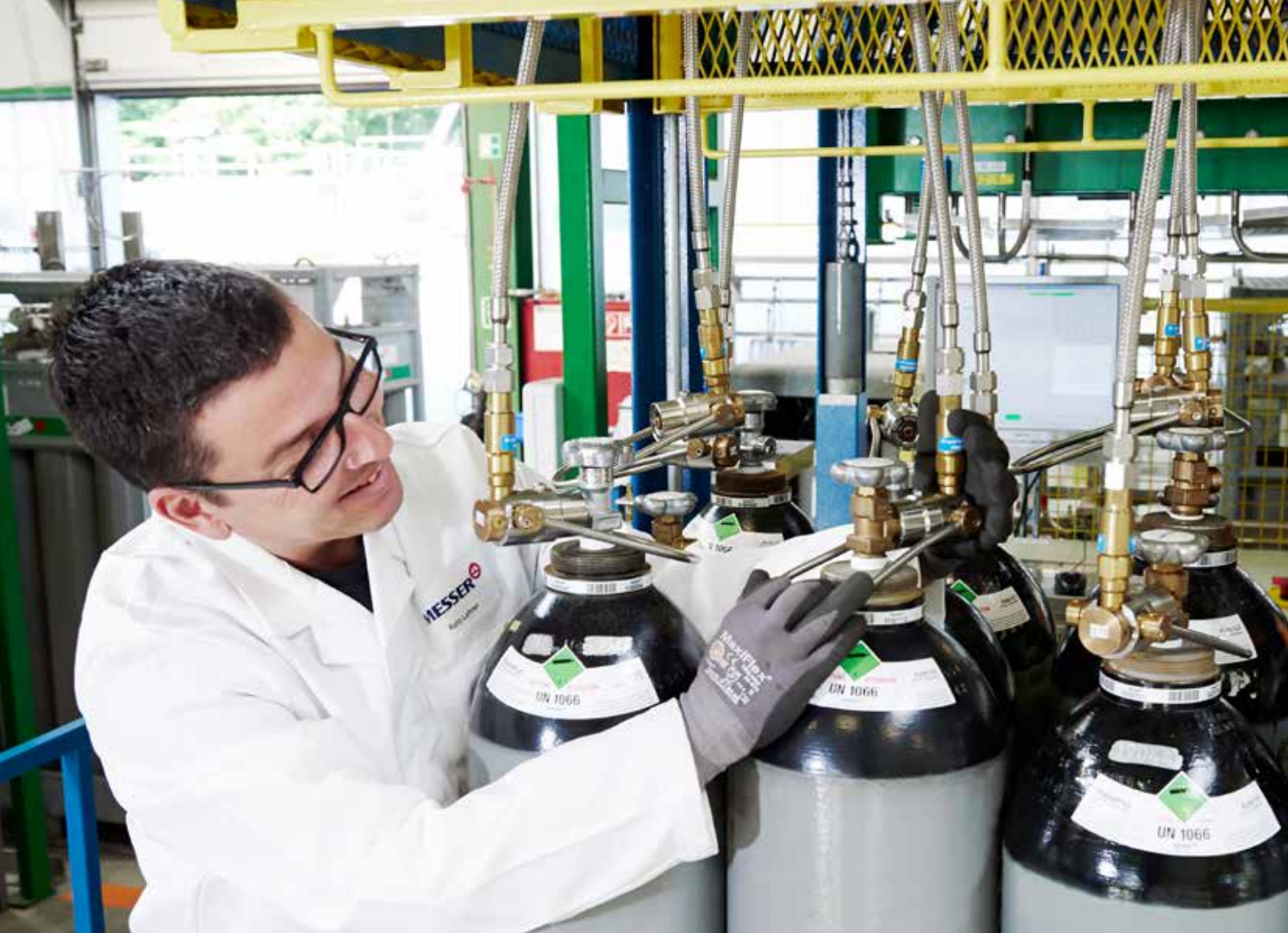
Station de remplissage pour gaz ultra-purs
