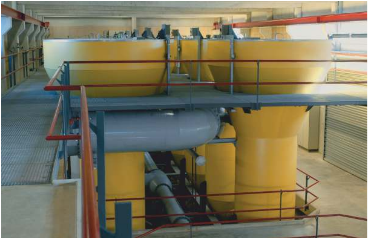
Obr. č. 5: Rychlá dekarbonizace ve fluidním loži s dávkováním oxidu uhličitého na výstupu reaktoru
