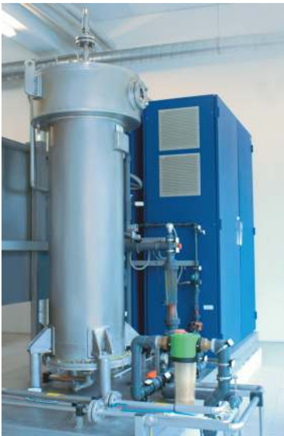
Obr. č. 10: Moderní generátory ozonu jako je toto zařízení o výkonu 3 kg O 3 /h používají čistý kyslík
