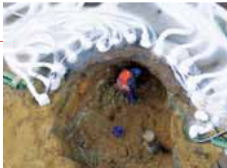
Durch Rohrleitungen wird flüssiger Stickstoff ins Erdreich geleitet.
