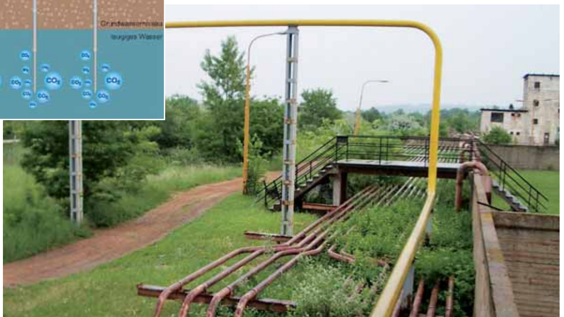
CO 2 wird unterhalb des Grundwasserspiegels injiziert. Das Kohlendioxid vermindert schonend den pH-Wert des basischen Wassers.
