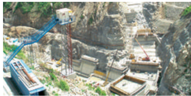
Einsatz von Betonkühlung im großen Maßstab
