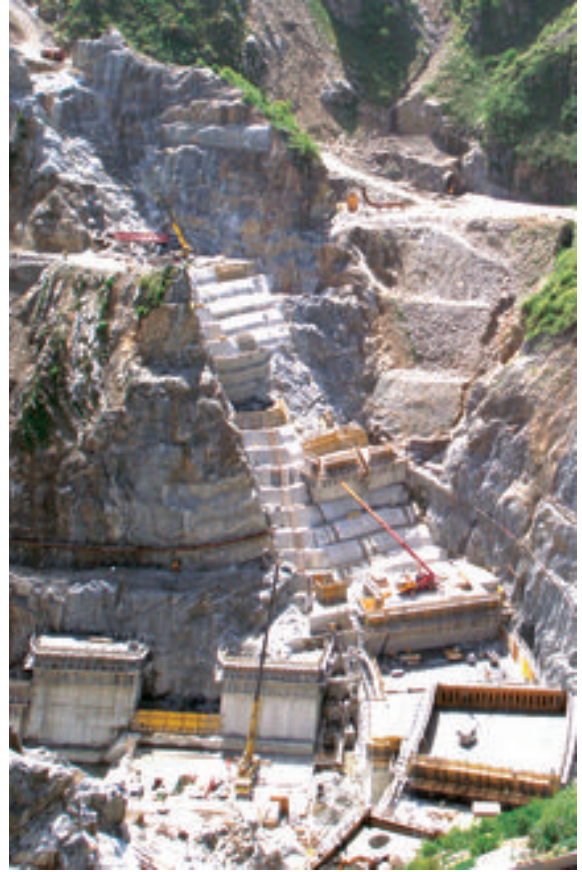
Großbaustelle Tsankov Kamak Hydro Power Plant, Bulgarien
