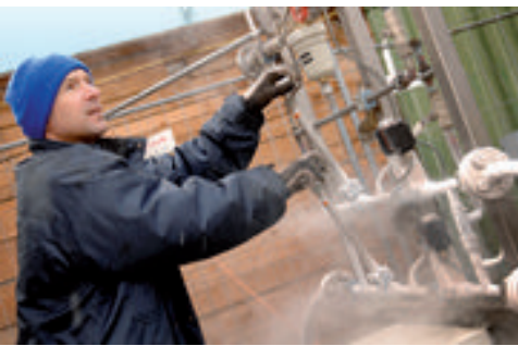
Einstellen einer Zementkühlungsanlage
