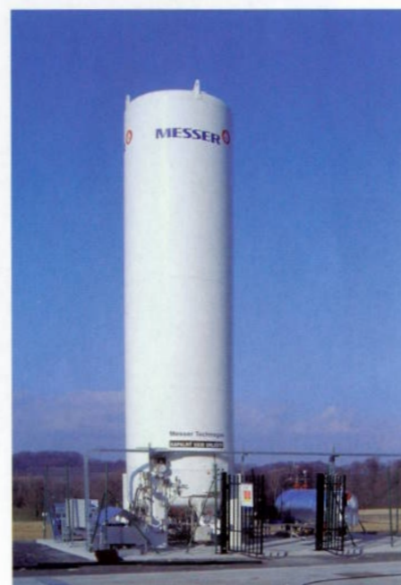
Zásobník kapalného CO 2 s kryogenními čerpadly
