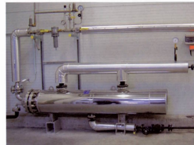
Parní odpařovač k přípravě vysokotlakého CO 2
