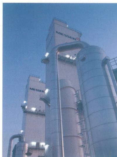
Die neuen Luftzerlegungsanlagen der Messer-Gruppe in Smederevo
